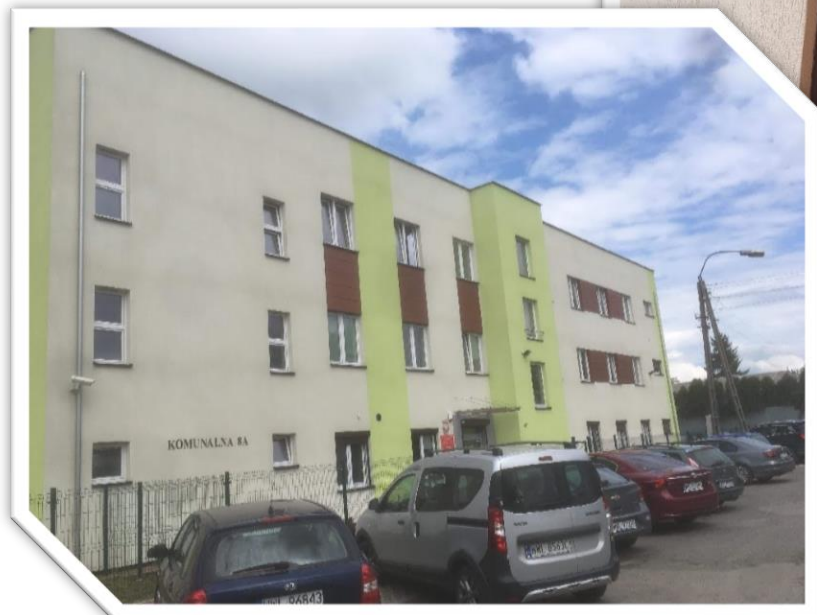
Fot. 4 nowa siedziba Filii Wydziałów Budownictwa i Komunikacji w Radzyminie przy ul. Komunalnej 8A
