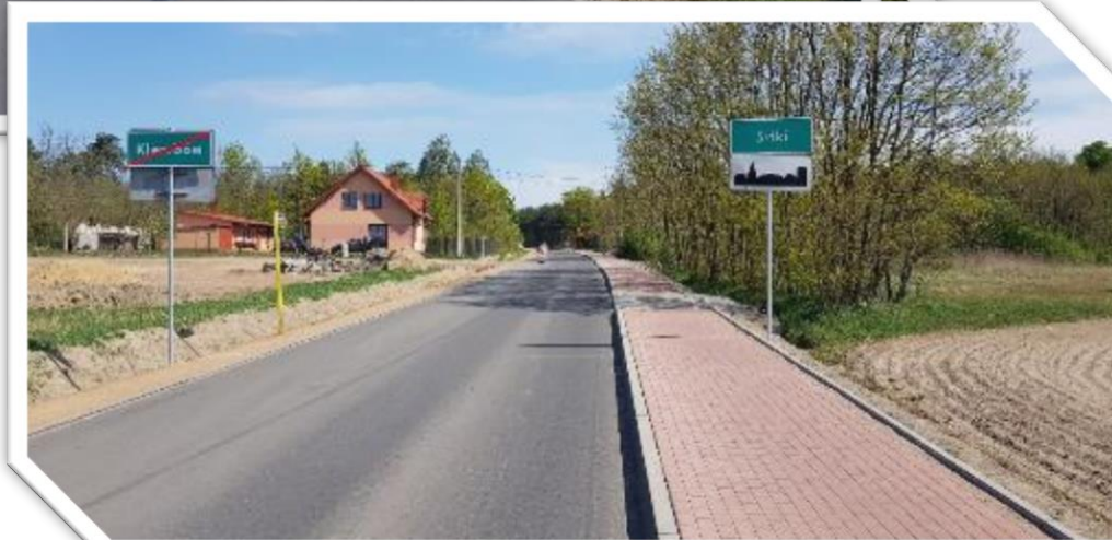
Fot. 45 przebudowa DP 4335W w Klembowie
