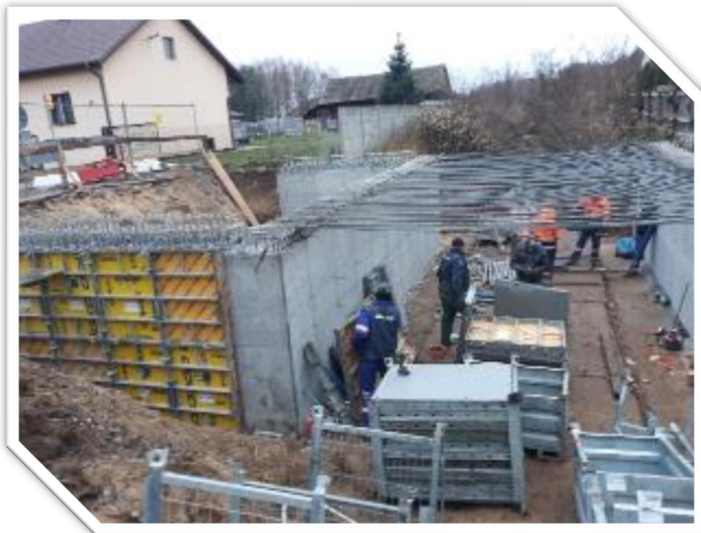
Fot. 47 rozbiórka i budowa nowego mostu nad rowem melioracyjnym w Dąbrowce
