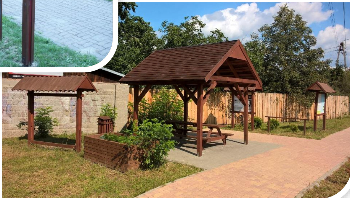
Fot. 54 konserwacja infrastruktury turystycznej
