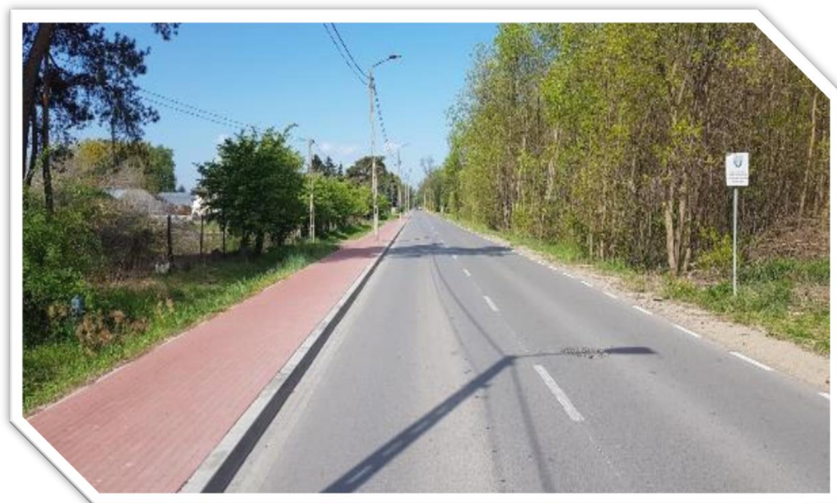
Fot. 37 przebudowa ul. Korczaka w Radzyminie
