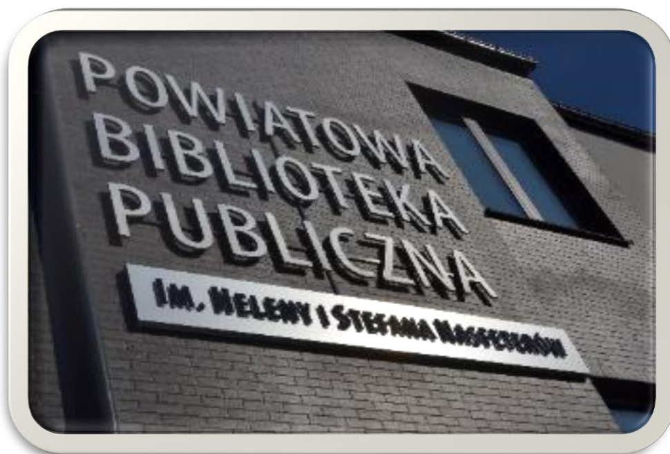
Fot. 12 elewacja frontowa PBP w Wołominie
