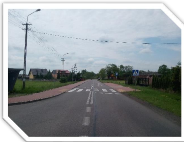
Fot. 32 remont drogi Mostówka - Ręczaje Polskie
