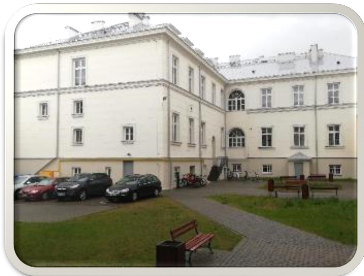
Fot. 11 LO Radzymiń, elewacja i dach
